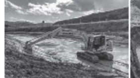
▲ICT建機による掘削・整地
