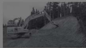
▲ICT建機による掘削・整地
